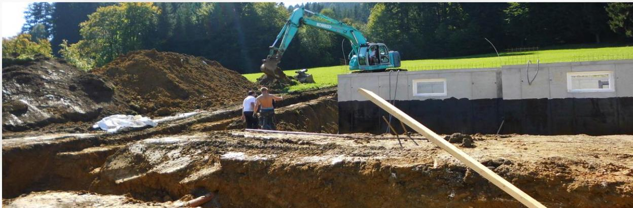
Die Erstellung der Kellerwände erfolgt ab Oberkante Sohlplatte, Ausführung nach Absprache als Betonwand (in WU-Beton). Die Innenwände sind ebenfalls massiv und werden errichtet gemäß statischem Erfordernis. Die Rohbauhöhe im Kellergeschoß beträgt 2,25 m im Lichten.
